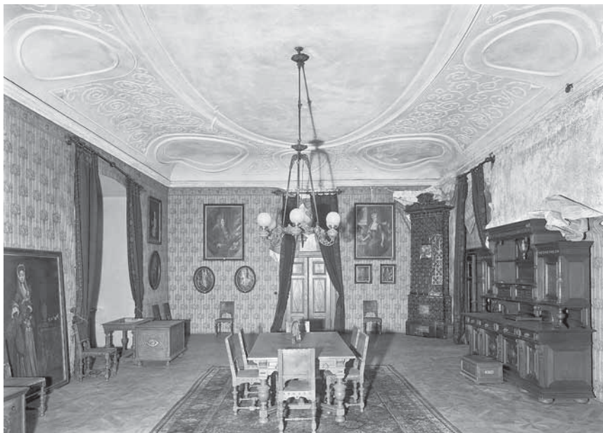
Obr. 1. Doudleby nad Orlicí (okres Rychnov nad Kněžnou), zámek. Vlhčí vzduch je lehčí. Destrukce tapet vpravo pod stropem jako doklad přítomnosti lehčího vlhkého vzduchu při velmi nízké teplotě. Zámek byl v roce 1949, v den pohřbu Michaela hraběte Bubna-Litic, zabrán původním majitelům, uzavřen a úředně zapečetěn. 2 V důsledku nevětrání a netemperování místností došlo v letech 1949–1950 k poškozením. (Foto Čestmír Šíla, 1950)
